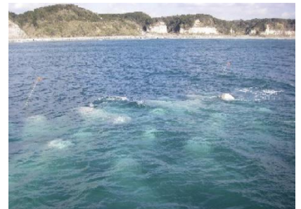
▽海岸保全施設（離岸堤）
