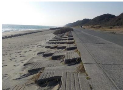
▽海岸保全施設（傾斜堤）
