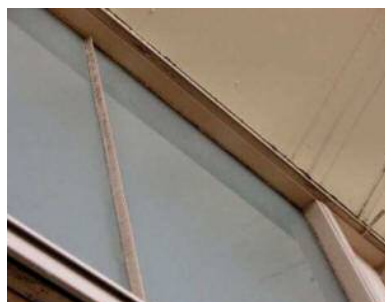
窓ガラスのはめ替え
