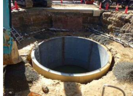
工事中的様子
