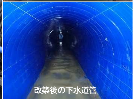
既設管の内側に新しい管を作っています
