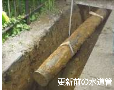
布設替工事の様子
