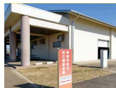
神栖中央公園内の防災備蓄倉庫
