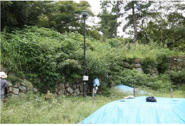
工事区域の石垣上に雑草が繁茂した状況（本丸東）
