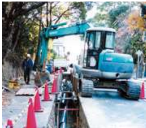
かん ちほけい う 下水道管(直径25cm)を埋める工事
