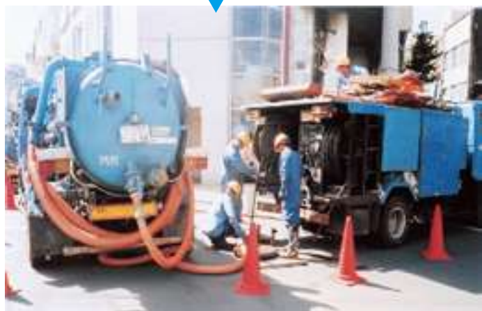
かん せいそう ▲下水道管の清掃
