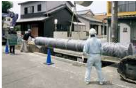
配水管を道路にうめる工事(現在)
