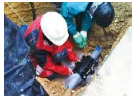
水もれの修理の様子
