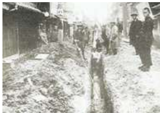
札木通りでの水道工事の様子(昭和2年ごろ)
