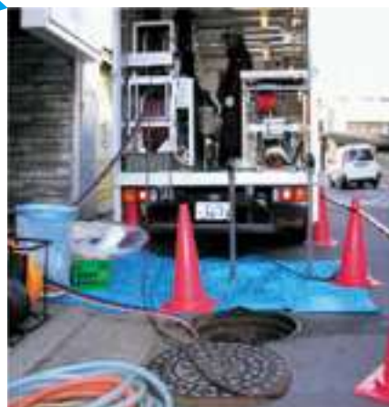
かん しゅうり ▲下水道管の修理
