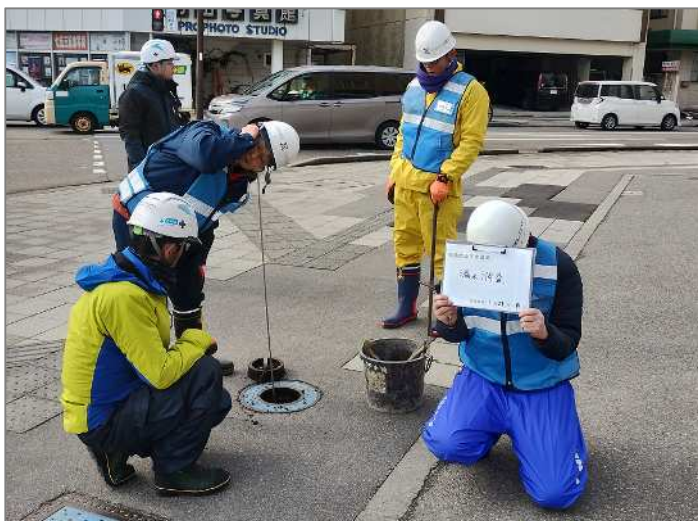
応急復旧 (水道)
