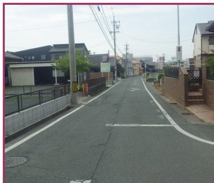
歩道がない道路の改良・整備
