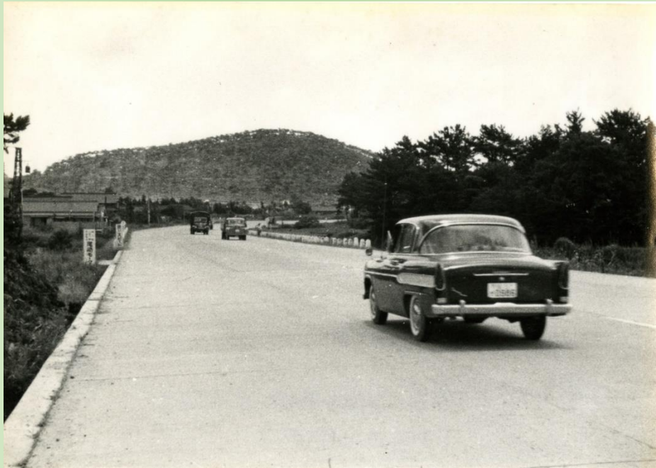
国道1号 撮影時期不明
