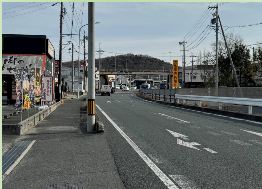
国道1号 撮影時期令和5年
