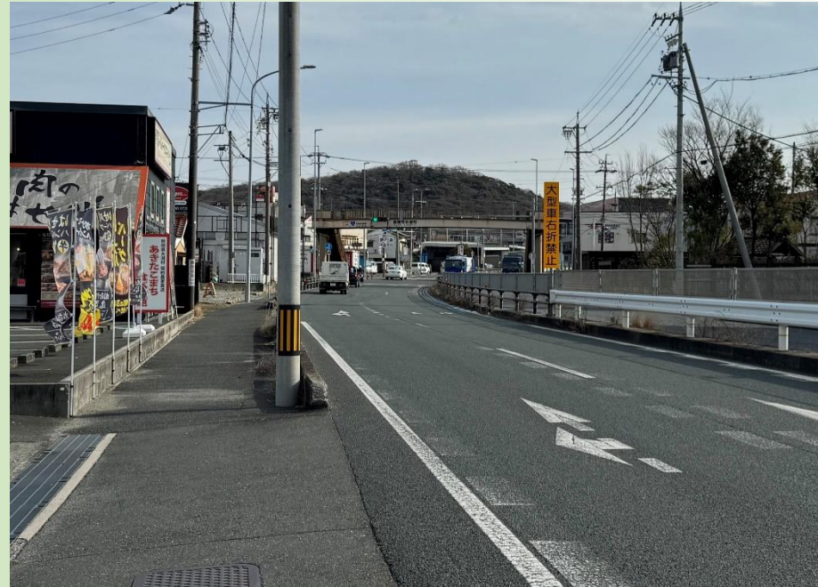
国道1号 撮影時期令和5年
