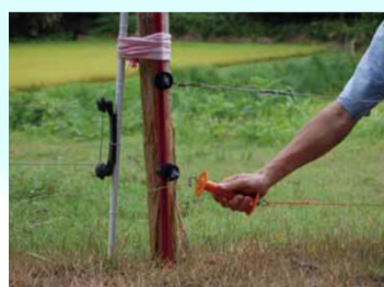
侵入防止柵の設置
