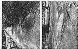
園内路 舗装の劣化や隆起した箇所が点在 車いす・ベビーカーでの移動が困難な上、 ジョギングやウォーキングでつまづく危険性も
