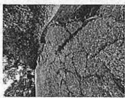
園内路 舗装の劣化や隆起した箇所が点在 車いす・ベビーカーでの移動が困難な上、 ジョギングやウォーキングでつまづく危険性も
