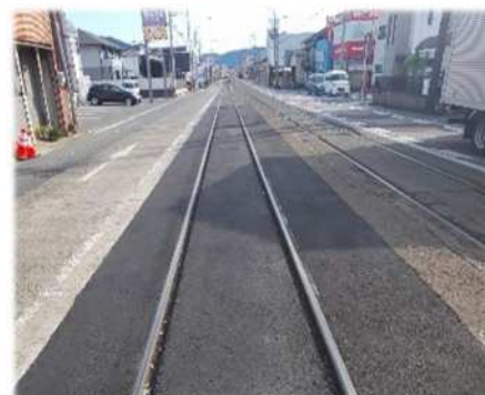
▲軌道敷改修後
