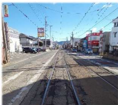
▲軌道敷改修前
