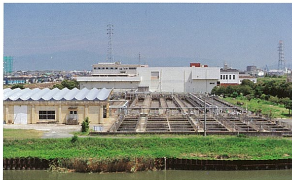
合流施設全景
