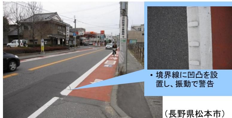
・境界線に凹凸を設置し、振動で警告
