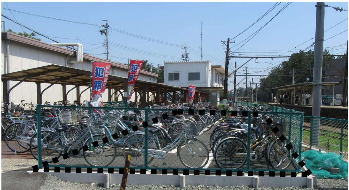
コンビニ裏駐輪場の軌道敷側に拡幅整備
