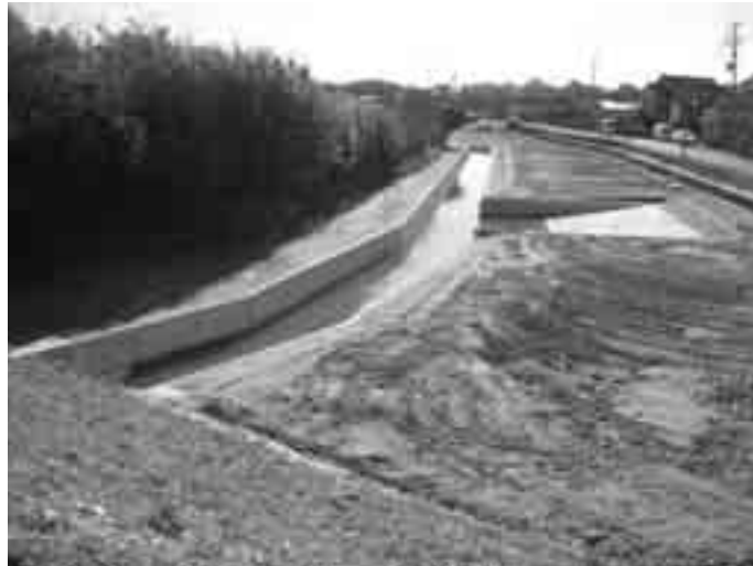
山崎川ヒガタアシ対策工事
