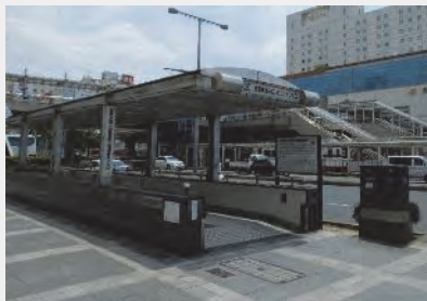
豊橋駅東口地下駐輪場の出入り口
