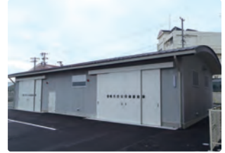
野依防災備蓄倉庫
