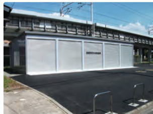
花中水防倉庫
