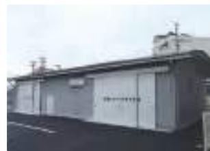
野依防災備蓄倉庫
