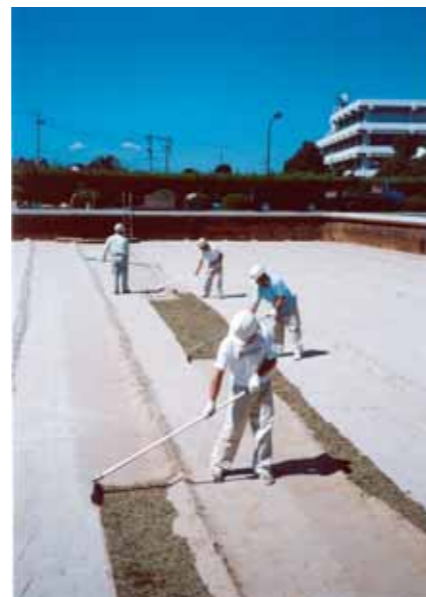
小鷹野浄水場でのろ過池の除砂作業
