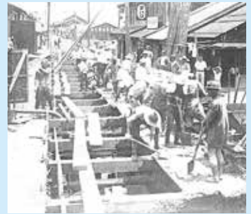
【船町の下水道幹線工事】
