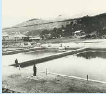
【野田処理場の第一沈殿池及びばっ気槽】
