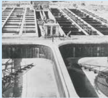
【野田処理場の第一沈殿池及びばっ気槽】
