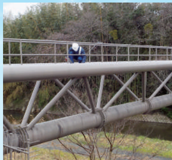
水管橋の目視点検状況
