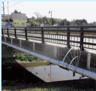
架け替えをした水管橋
