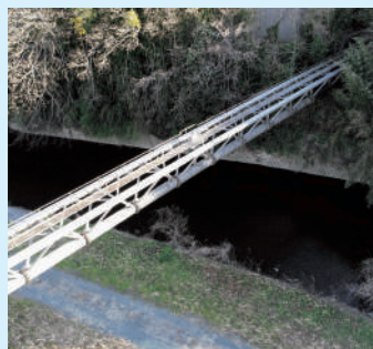
ドローンから撮影した 水管橋の様子
