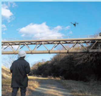
ドローンによる点検状況 (豊橋市ドローン飛行隊撮影)
