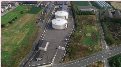
新設された東部配水場 (令和2年度)
