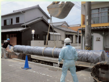
水道管布設状況
