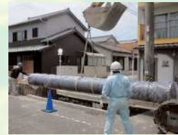
水道管布設状況
