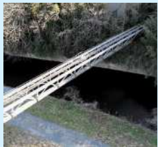
ドローンから撮影した水管橋の様子
