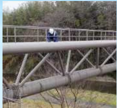
水管橋の目視点検状況
