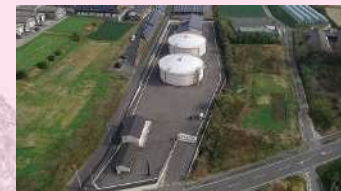
新設された東部配水場 (令和2年度)
