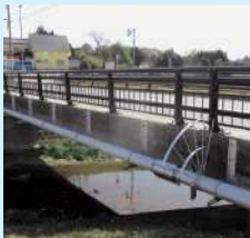
架け替えをした水管橋
