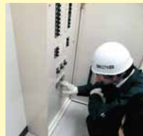
▲ 定期点検の様子
