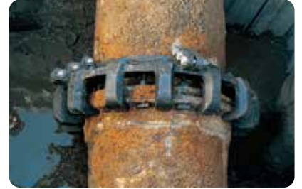
水道管の補強
