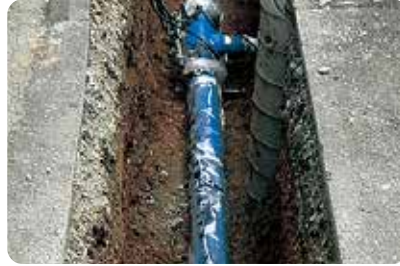
水道管の更新
