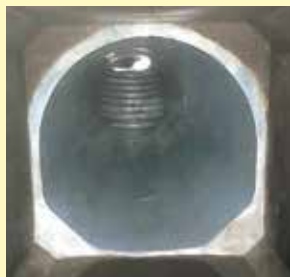
▲ 工事完了の様子
