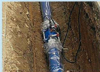
耐震管接合の様子
