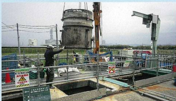
老朽機器更新の様子(中島処理場)
