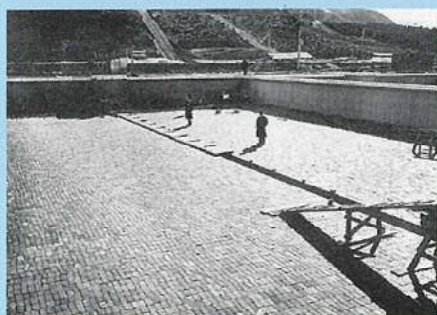
ろ過池の工事(レンガ敷き)
