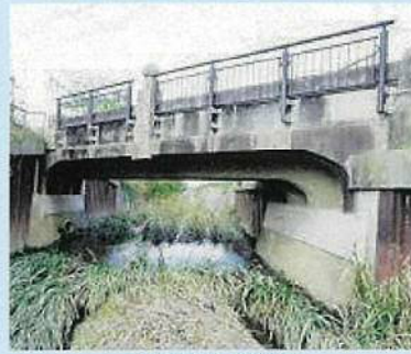
大江川水道橋
