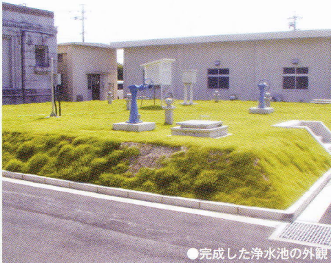
●完成した浄水池の外観
