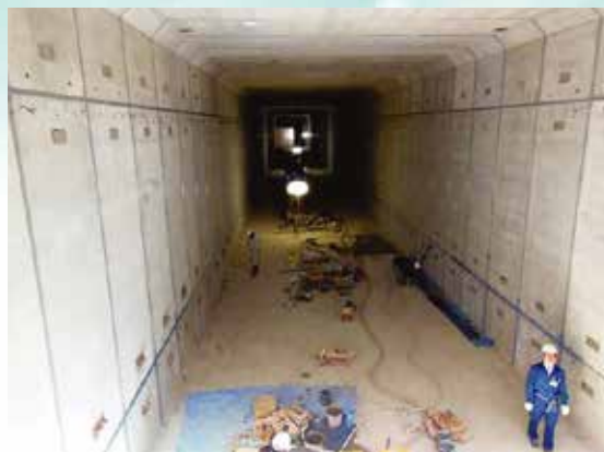
雨水貯留施設(前田南雨水調整池)
