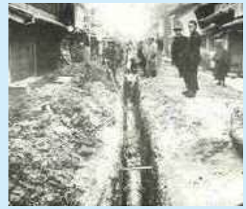
【船町の下水道幹線工事】
