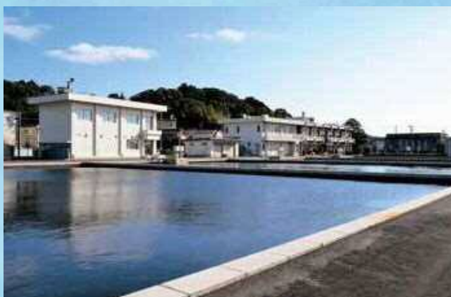
小鷹野浄水場
