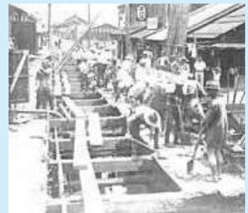
【船町の下水道幹線工事】
