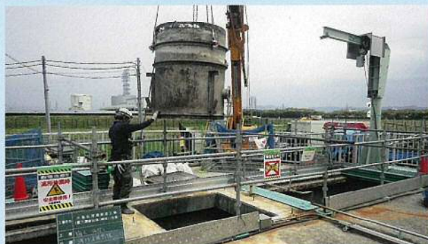
老朽機器更新の様子（中島処理場）
