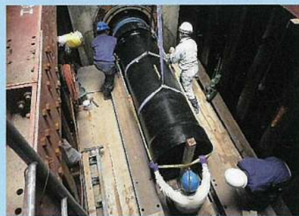
現在の水道管埋設工事
