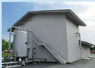
新設した伊古部給水所
