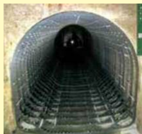
▲工事中の様子
