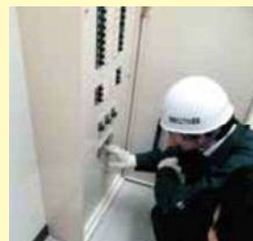
▲定期点検の様子
