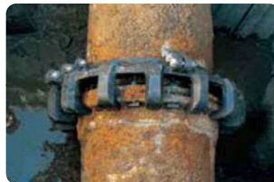
水道管の補強
