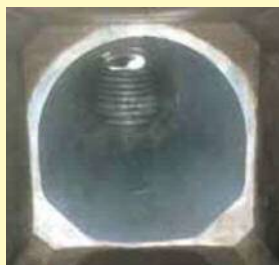
▲工事完了の様子
