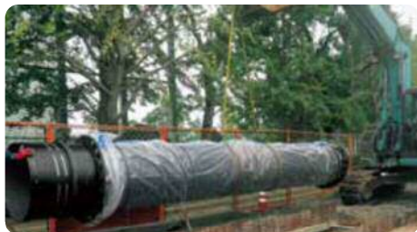
地震に強い大きな水道管の設置
