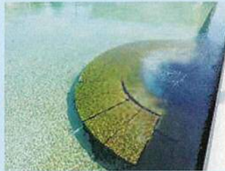
ろ過池への流入口
