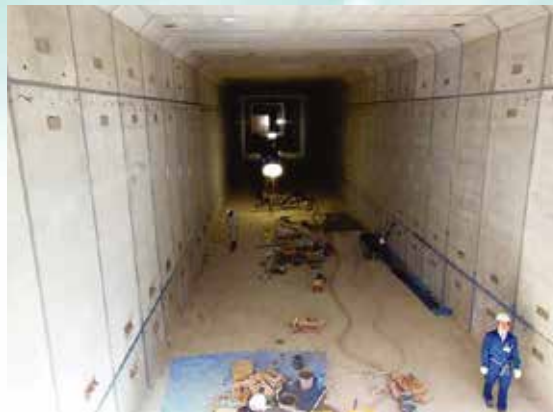
雨水貯留施設(前田南雨水調整池)
