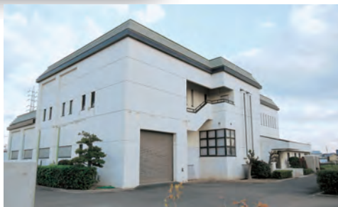
松島ポンプ場[雨水] 豊橋市牟呂町地内 (平成9年度運転開始) 雨水排水能力 805m 3 /分
