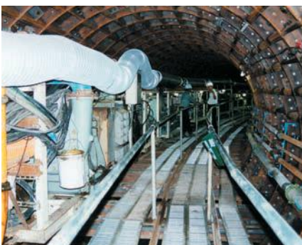
直径3mの雨水管を造る下地雨水幹線工事
