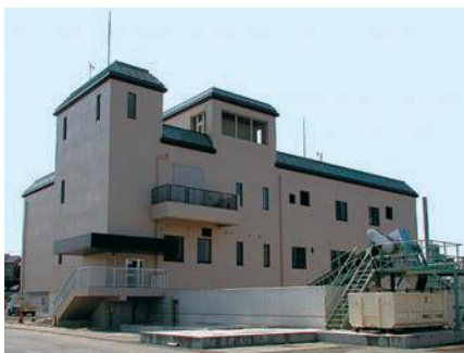
下地ポンプ場〔雨水〕 豊橋市下地町地内 (平成16年度運転開始) 雨水排水能力 709m 3 /分
