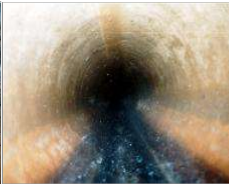
せいそう かん 清掃後の下水道管
