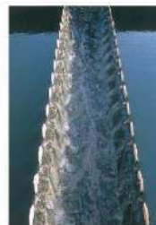
ちんでんち ④最終沈殿池 きれいになった水と 重くなった微生物を 分ける
