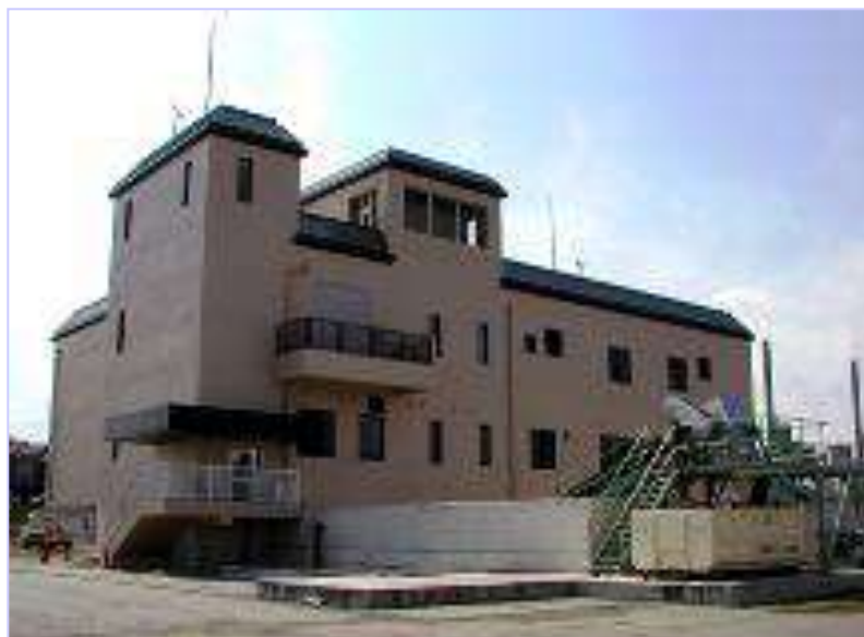
しもじ 下地ポンプ場
