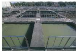
ちんでんち ②最初沈殿池 しず よご 沈みやすい汚れを 取り除く
