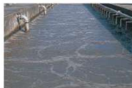
はんのう ③反応タンク おすい びせいぶつ 汚水に微生物を入れて、 ふ こ びせいぶつ 空気を吹き込む。微生物は、 よご 水の中の汚れを食べて 重くなります。
