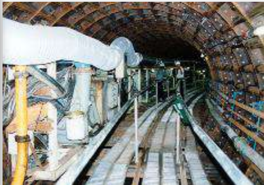
ちよっけい 直 経 3m の下水道トンネル工事
