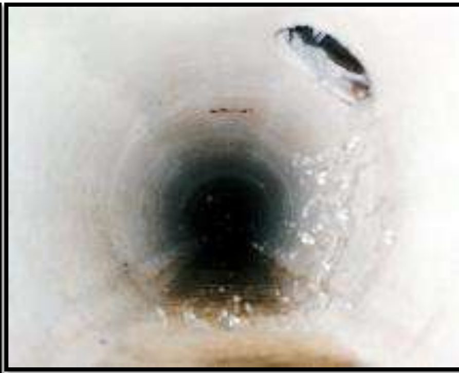
しゅうり かん 修理後の下水道管
