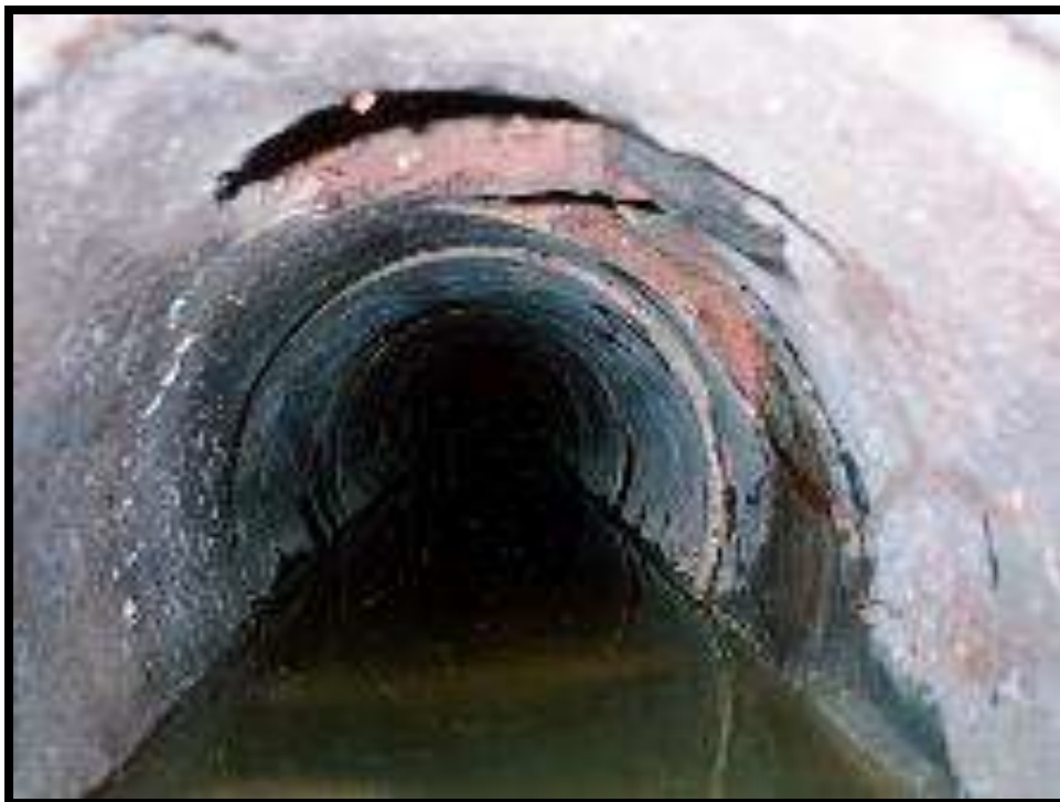
しゅうり かん 修理前の下水道管
