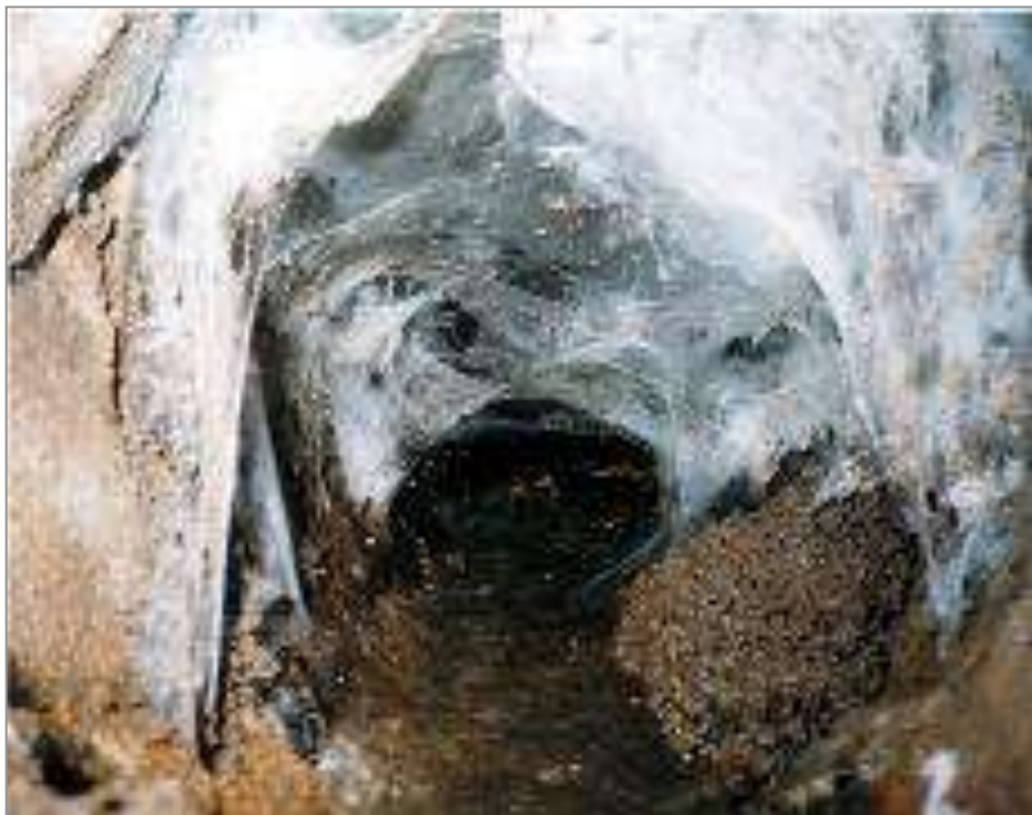
せいそう かん 清掃前の下水道管
