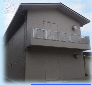
写真 高山配水場
