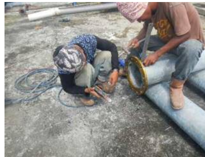
ポンプ吸込配管改良 (φ100→200)
