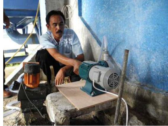
日本製薬液ポンプの活用 （長寿命、注入量の安定化）
