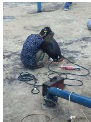
ポンプ吸込配管改良 (φ100→200)
