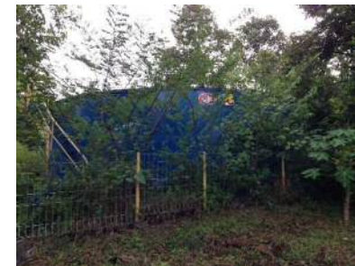
配水池 (標高差160m?)
