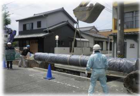
水道管耐震化工事の様子
