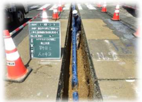
水道管耐震化工事の様子
