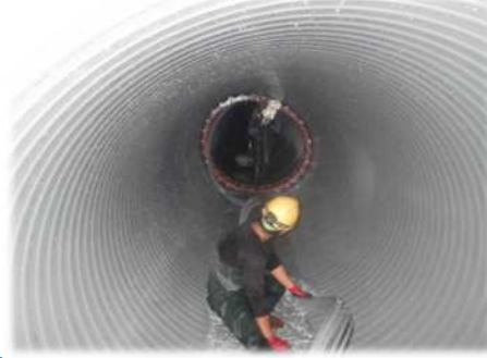
下水道管更生工事の様子
