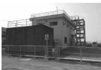
吉田方排水機場
