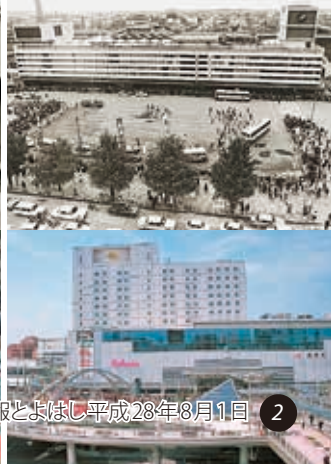
⑧ 豊橋駅(上:昭和45年に完成した豊橋ステーションビル、下:現在)
