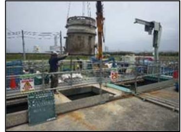
【老朽化した処理場の改築工事】
