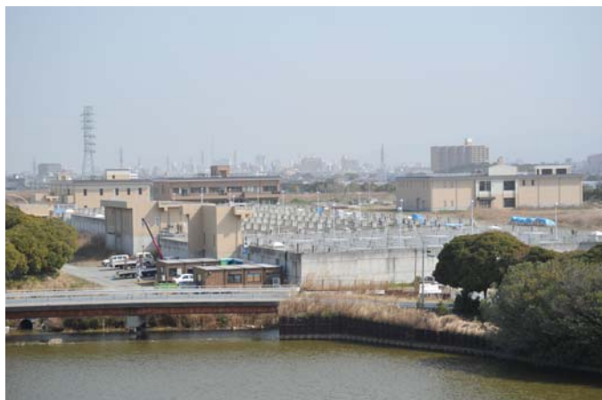
分流処理施設を建設中の中島処理場
