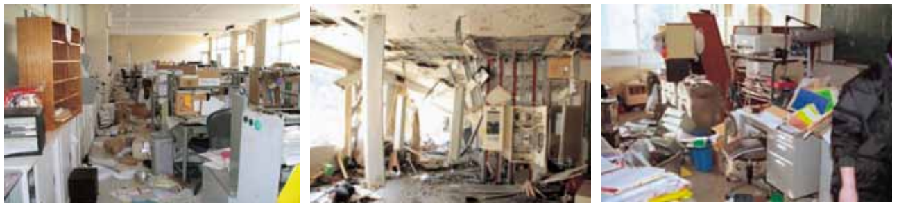
東日本大震災における職員室の様子
