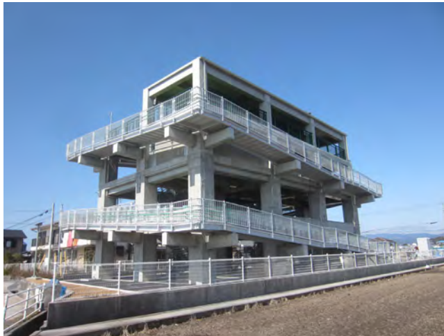
図 1-3 津波避難タワー
