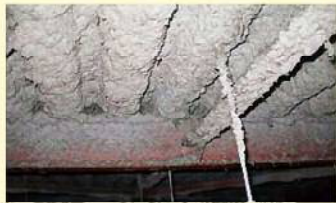
事務室の天井裏
