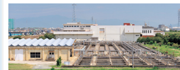
合流施設全景
