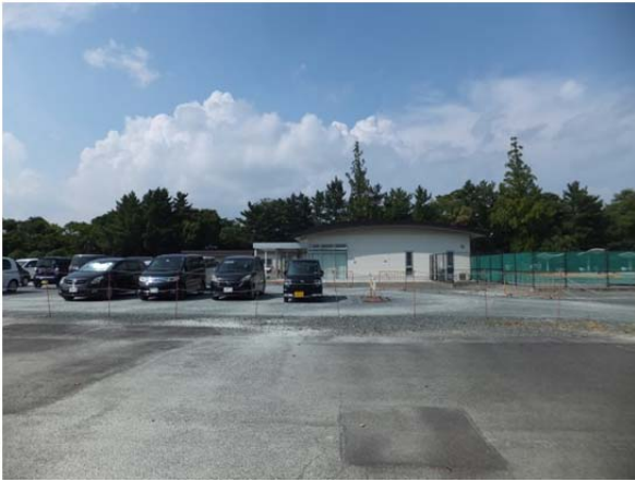
プール管理棟
