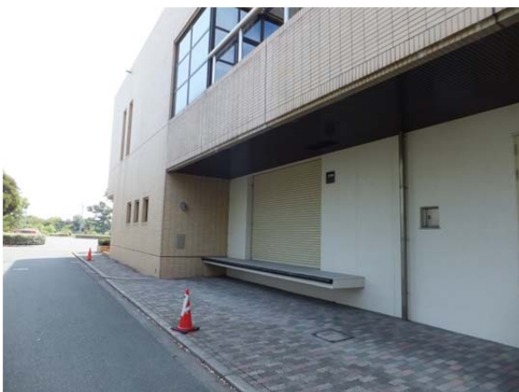
総合体育館東側搬入口
