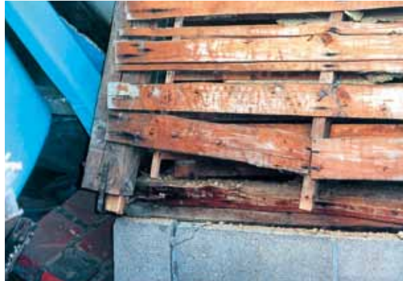
地震による大きな引き抜き力で、抜け出してしまった筋かい端部(左写真)と、柱の脚部(上写真)
