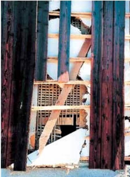
地震による大きな引き抜き力で、抜け出してしまった筋かい端部(左写真)と、柱の脚部(上写真)
